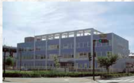
横須賀商工会議所 新庁舎完成
