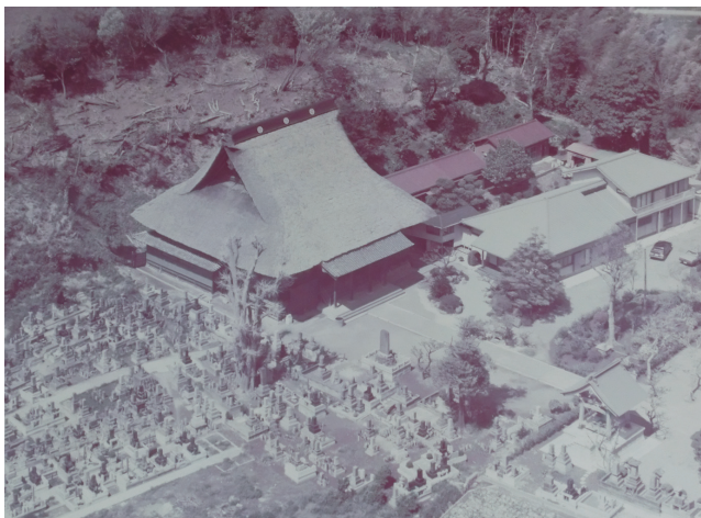
昭和62年に改修する前の茅葺屋根の本堂
