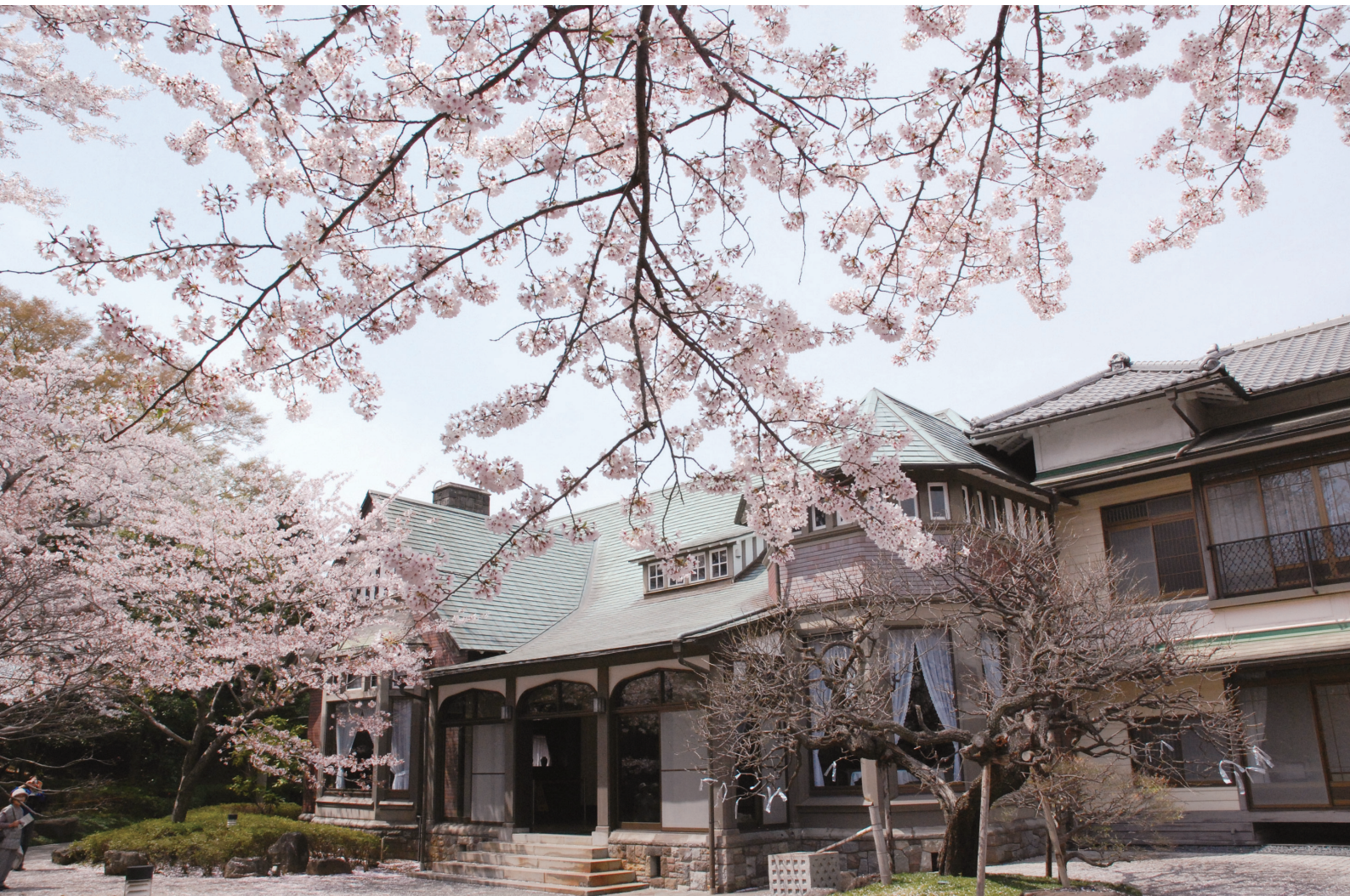
田戸台分庁舎の桜 海上自衛隊横須賀地方総監部の田戸台分庁舎は、京急県立大学駅の裏手、東京湾を一望する小高い丘の上にあります。大正2年、旧海軍横須賀鎮守府長官の住まいとして建てられ、終戦まで34代の長官が居住していました。桜の名所としても知られ、開放されると多くの花見客が訪れます。 (写真/稲毛 敦子)
