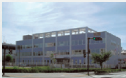
横須賀商工会議所 新庁舎完成
